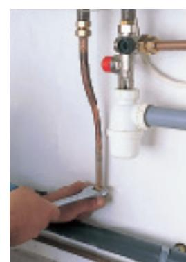
**22. Raccorder le siphon à la canalisation d'évacuation avec du tube PVC de 32 mm de diamètre.**
