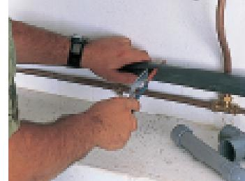
**24. Sur la canalisation existante, tracer la longueur à couper sans oublier la pénétration des tubes dans le raccord.**
