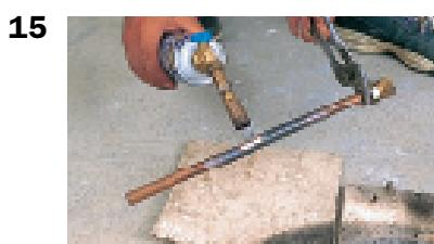
**15.** Couper le morceau de tube et l'équiper d'un raccord rapide. Au besoin, le recuire afin de le cintrer légèrement pour faciliter le raccordement.
