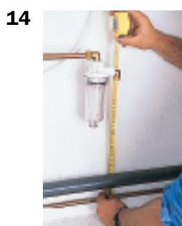
**14.** Mesurer la longueur de tube de cuivre nécessaire pour relier le filtre à la canalisation d'alimentation existante.
