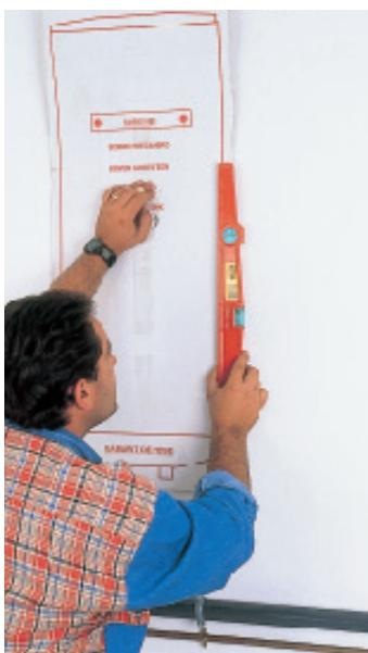
**1. Le chauffe-eau est accroché au mur, au-dessus des canalisations d'arrivée d'eau froide (en cuivre) et d'évacuation (en PVC). Positionner le gabarit de perçage du chauffe-eau avec un niveau à bulles.**
