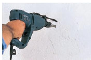
**3. Percer le mur à la perceuse à percussion, ou au marteau perforateur, au diamètre des chevilles.**
