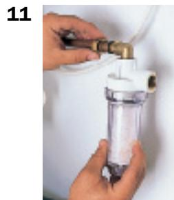
**11.** L'assembler au tube de cuivre par un autre raccord rapide à collet mobile.
