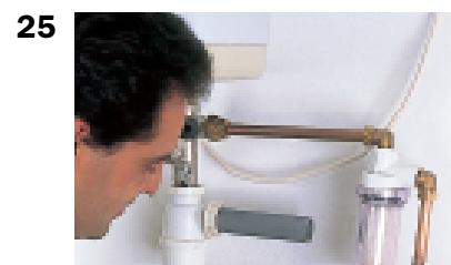
**23. La canalisation existante étant en tube de 40 mm de diamètre, utiliser une réduction à coller dans le raccord en té.**
