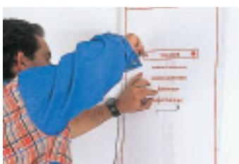
**2. Marquer les trous de perçage avec un poinçon.**
