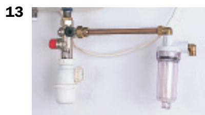
**13.** Pour intercaler le filtre à tartre, on réalise un raccordement rigide (en cuivre). Si on n'installe pas de filtre, on peut utiliser un flexible de raccordement.
